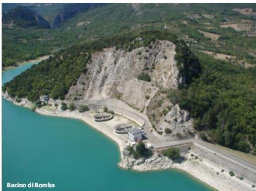
Il LAGO di BOMBA, avente un volume utile d'invaso di progetto di circa 64 milioni di mc è alimentato dal fiume SANGRO: l'opera di sbarramento è stata realizzata mediante una DIGA in TERRA, con una lunghezza di 681 m e un'altezza superiore ai 57.50 m. Le opere di scarico sono costituite da n.2 scarichi di superficie costituiti, all'imbocco, da due calici
